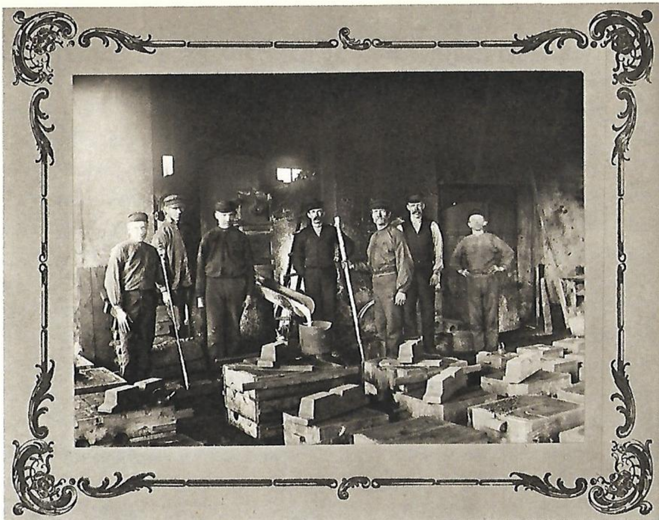
Interiör från gjuteriet omkring 1905.
