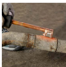
Demontering av avgasrör
