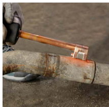
Demontering av avgasrör
