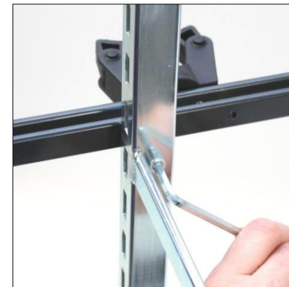
Montera modulramen mot styret i de gängade hålen enligt bild.
