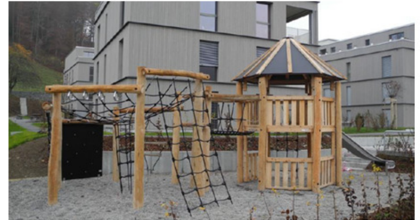
Färgobehandlad Robinia nyligen installerad
