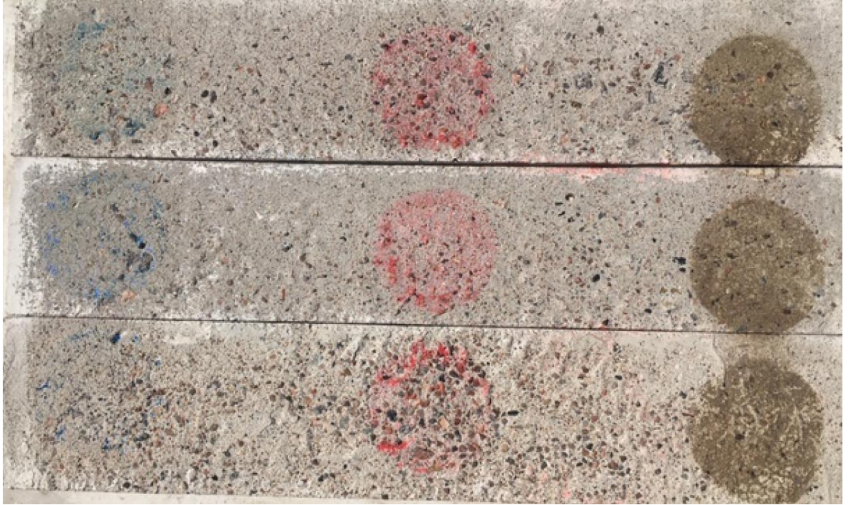
Provytan efter sanering, färg 1-5
