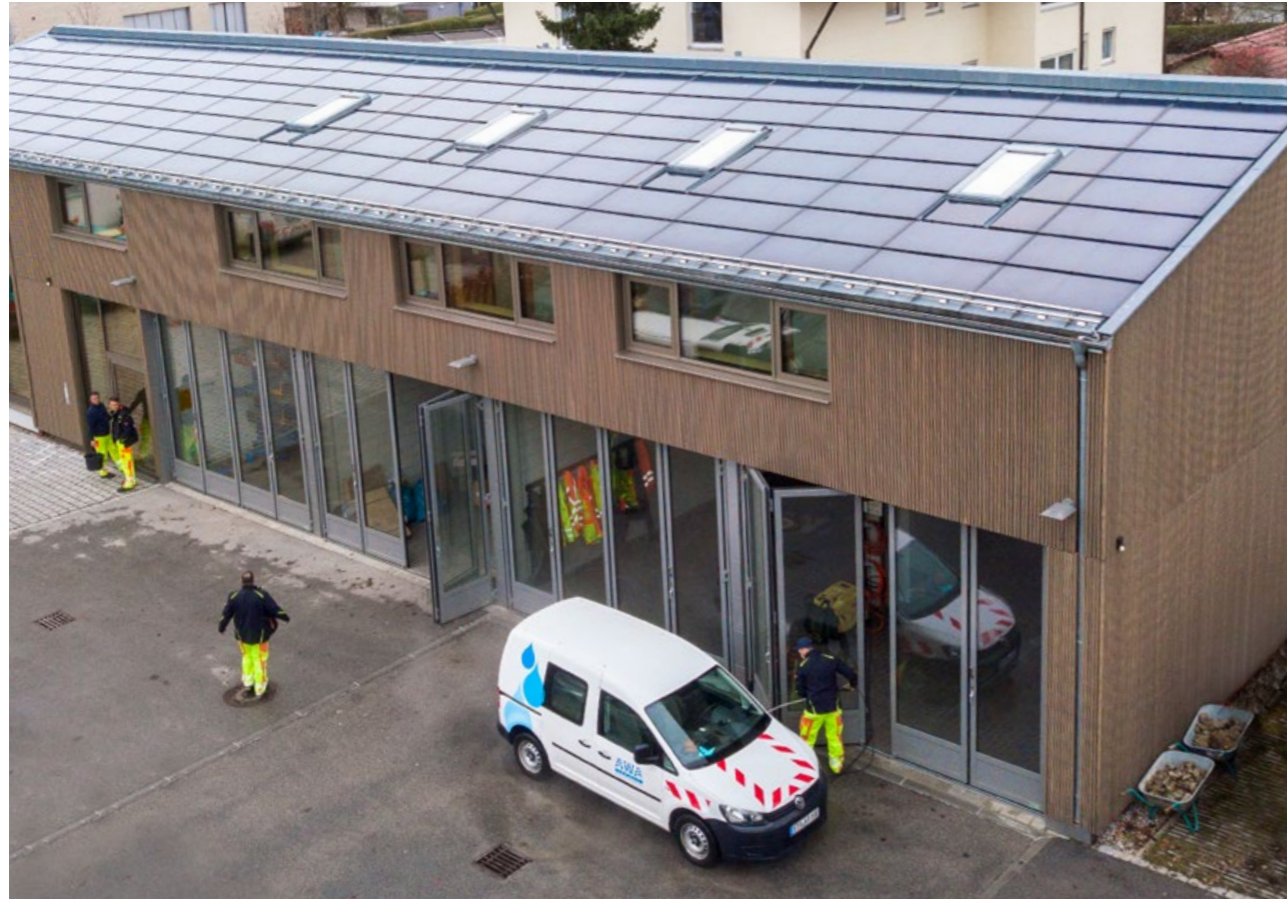
AWA-Ammersee Wasser- und Abwasserbetriebe gKU, operations building Herrsching (Germany)
