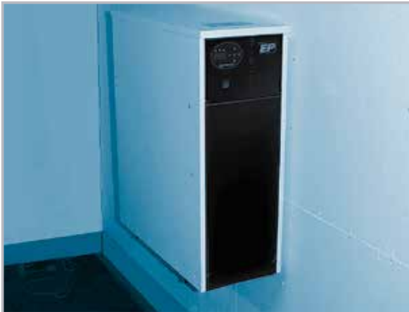
Pannan kan vara golvstående eller väggmonteras med konsoler (tillbehör).
